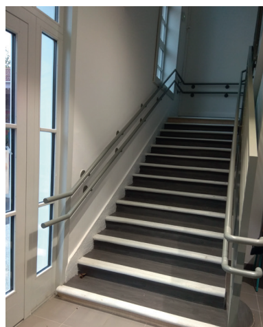
Réalisation d'un nouvel escalier au sein du groupe scolaire Lumière (8 ème arrondissement) ©Ville de Lyon
