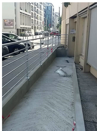
Nouvel accès à la crèche Saint Lazare après travaux (7 ème arrondissement) ©Ville de Lyon
