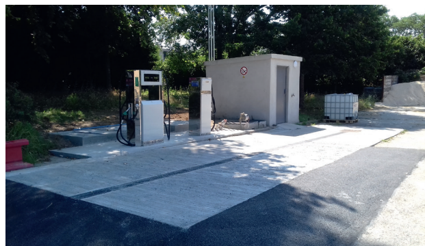
La nouvelle station de distribution de carburant à Gerland (7 ème arrondissement) ©Ville de Lyon
